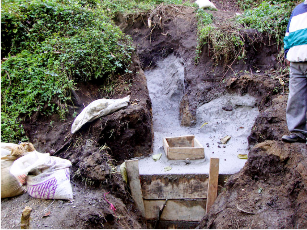
-versiegelung – Schutz vor Verunreinigung
